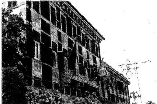
La facciata di Palazzo Franzoni, il municipio di Lavagna
