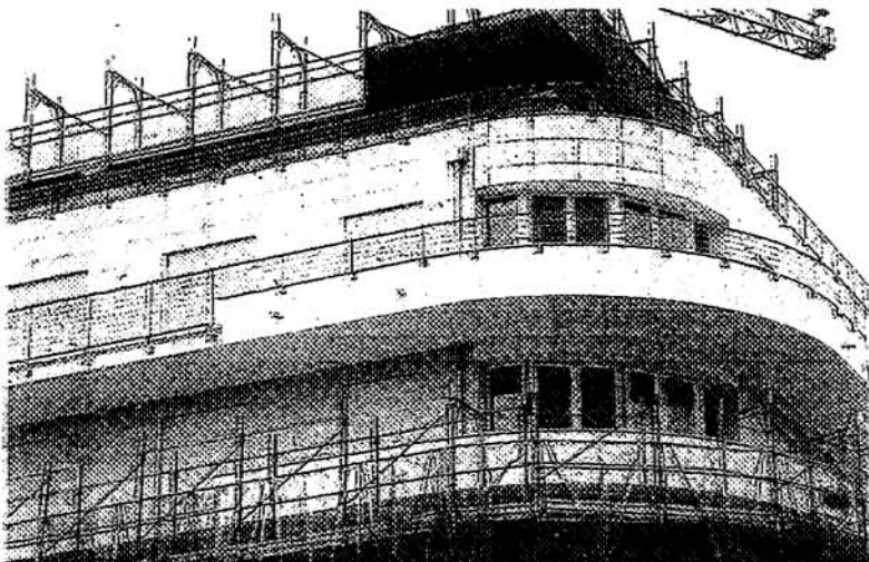
Un particolare della struttura residenziale praticamente ultimata FLASH
