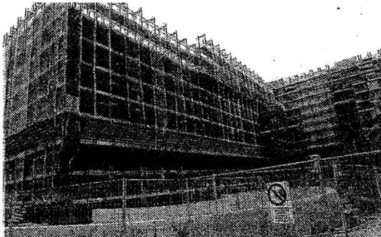
Un'immagine del cantiere dell'ex albergo Astoria di Cavi Arenelle FLASH
