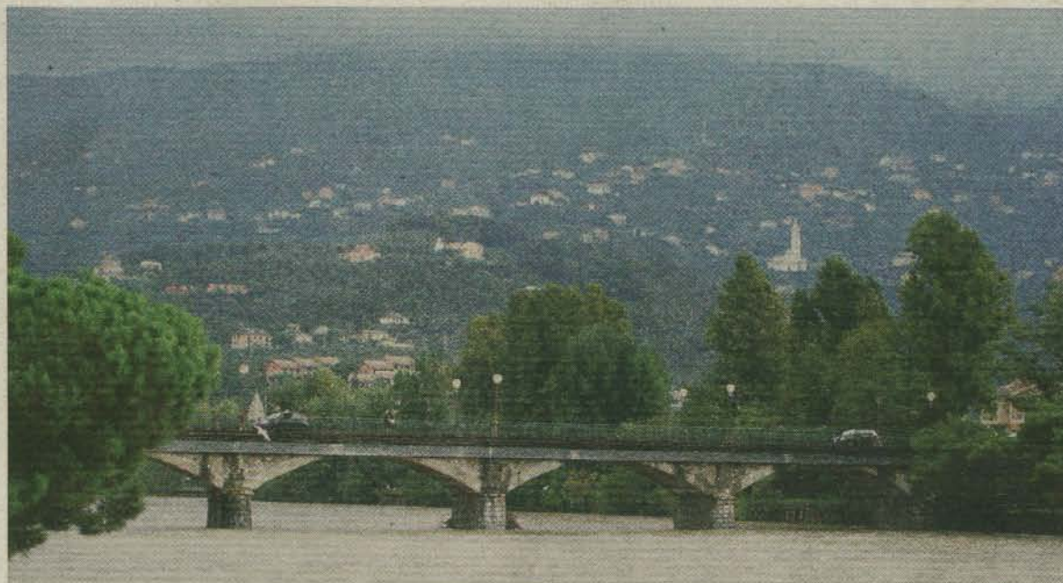
Il ponte della Libertà tra Chiavari e Lavagna di cui si prevede la demolizione e sostituzione
