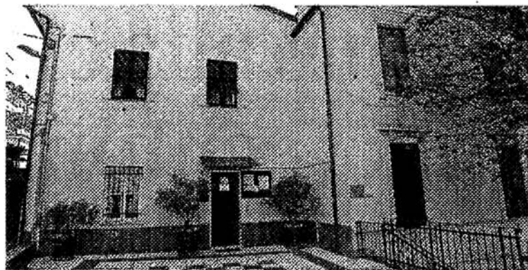
L'edificio che un tempo ospitava la scuola di Cavi, a Lavagna FLASH
