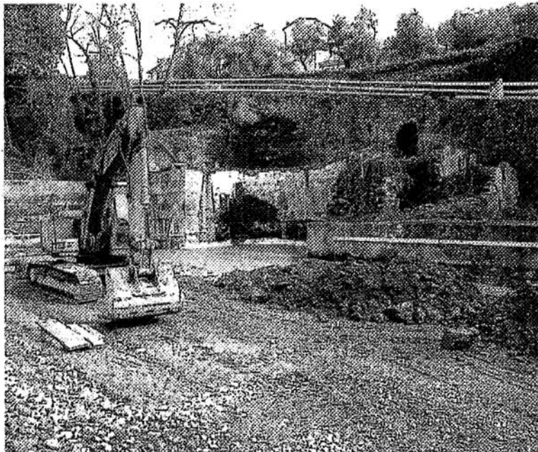
Il cantiere nel giardino di Villa Spinola a Lavagna
