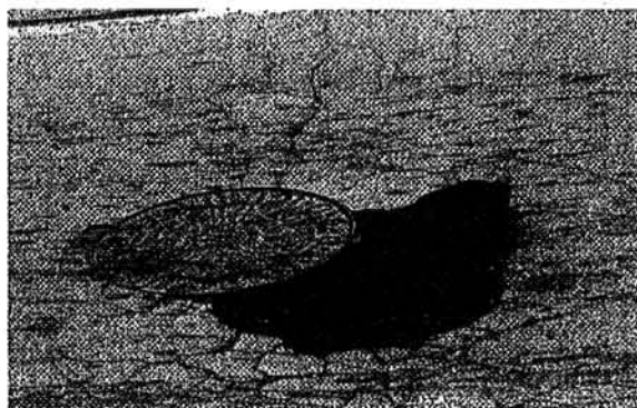
Un rattoppo nella zona della stazione di Lavagna
